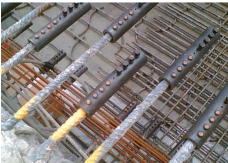
Manchons MBT dans une dalle et positionnés en décalage
