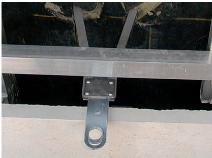
HALFEN GE-HB Gerüstanker für Natursteinfassaden
