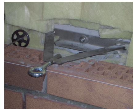
HALFEN HGA-Q Gerüstanker mit kurzer Ringschraube. Die seitlichen Verstrebungen nehmen Kräfte parallel zur Fassade auf.
