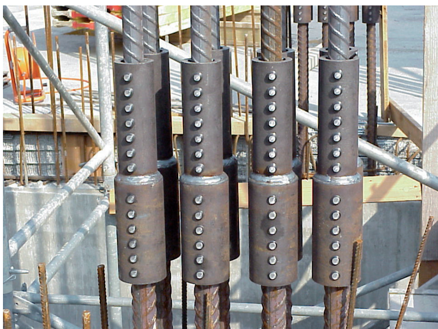
Stützenfuß mit Reduziermuffen
