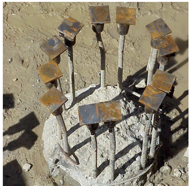
Detail der Endverankerung in einem Bohrpfahl
