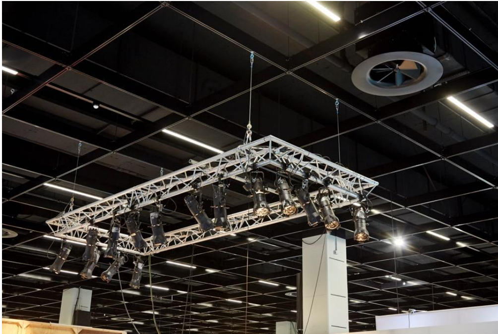
Einsatz von Versogrid im Projekt: Koelnmesse GmbH, Deutschland / Foto: ©tomjasny.com
