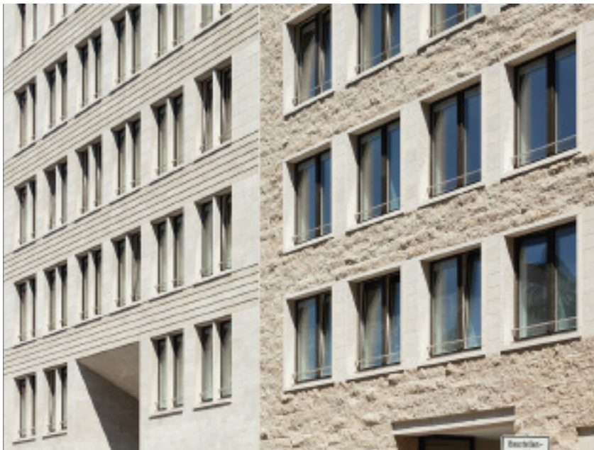
Vorgehängte Fassade gemäß Passivhausstandard: Neubau der Stiftung Waisenhaus Frankfurt/Main Foto: Schön + Hippelein, Natursteinwerke
