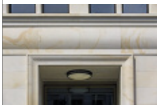
Dominium in Köln mit hinterlüfteter Natursteinfassade aus Hohenzollernpark Sandstein Foto: Hofmann Naturstein
