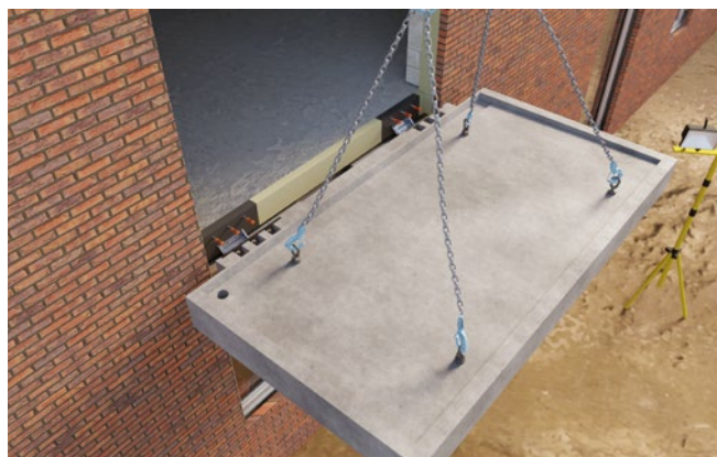
Während der Montagephase auf der Baustelle werden die Balkone vom Lkw gehoben und in wenigen Minuten mit dem Gebäude verbunden. | During the installation phase on the building site, balconies are lifted from the truck and connected to the building frame in a few minutes.
