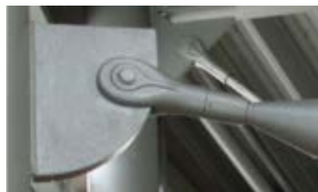
Dragstagssystem anslutet till svetsad anslutningsplåt
