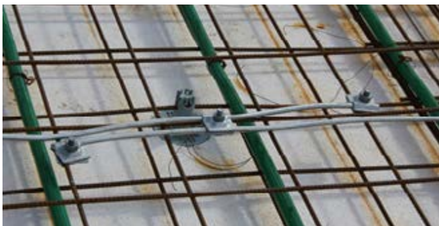
Skarv av linan görs med multiklämma.
