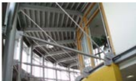
Dragstag mellan utvändig stålpelare och invändig stålbalk
