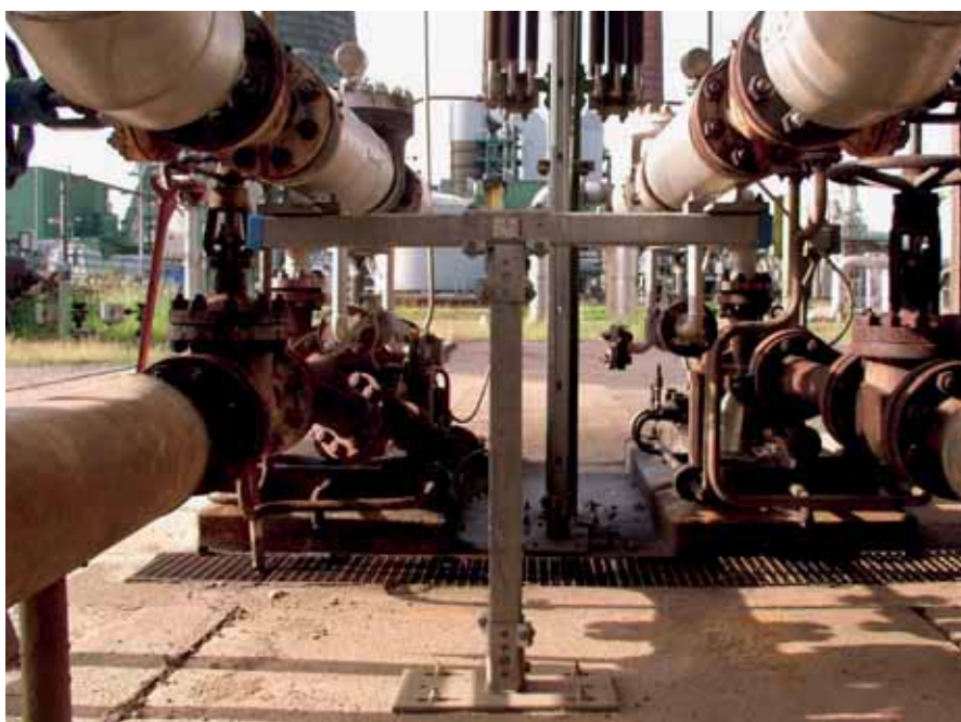
Montage simple d'une construction en T avec HALFEN Powerclick
