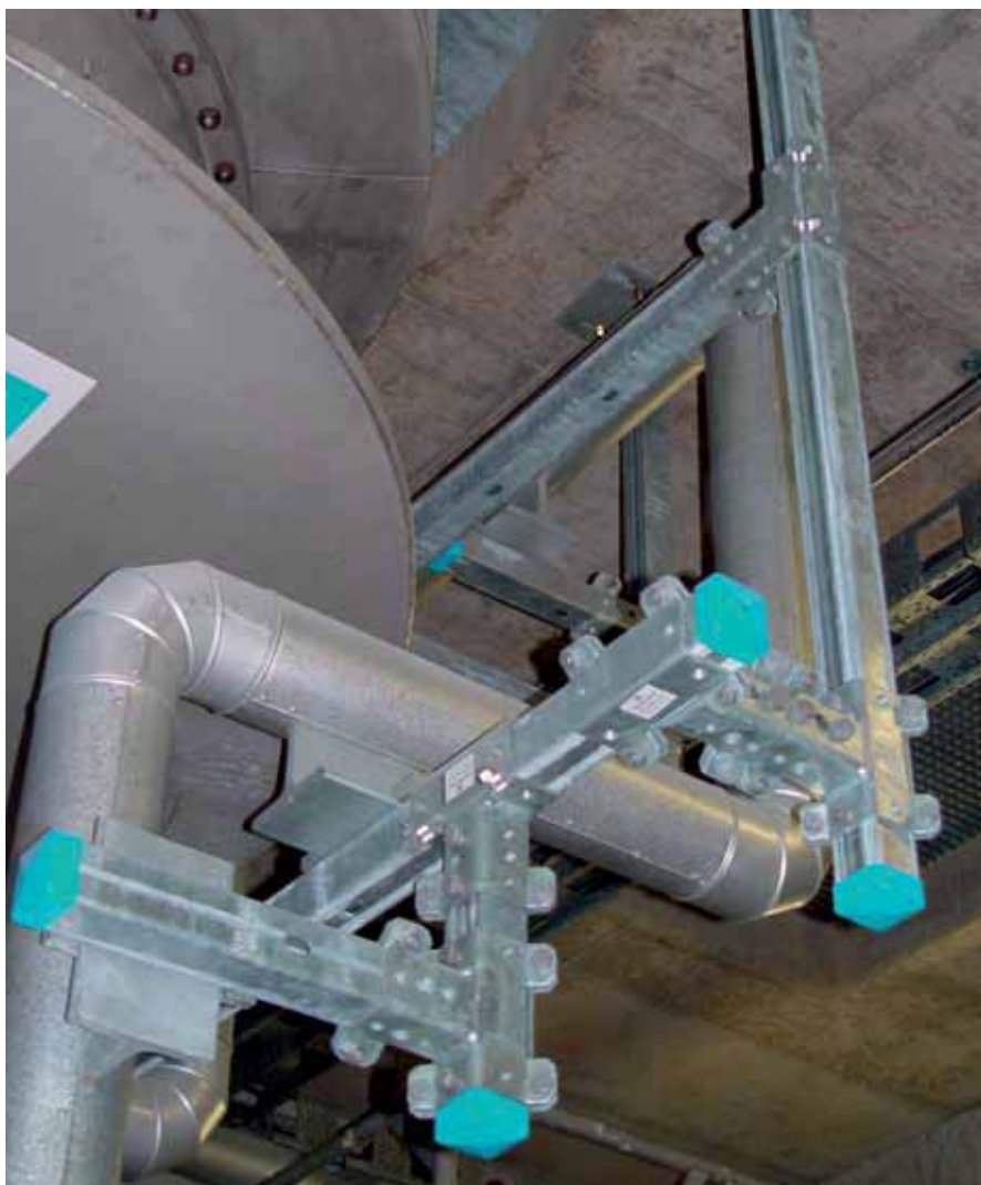
Applications flexibles avec un seul rail et deux pièces de liaison
