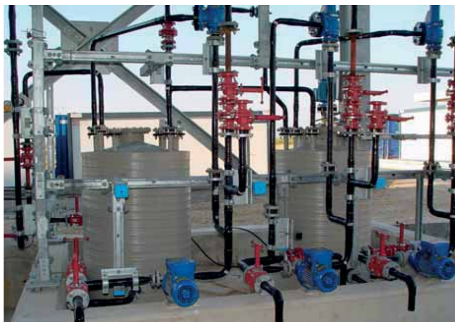
Raccordement dans toutes les directions grâce à des pièces de liaison multifonctionnelles.
