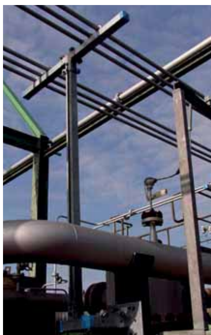
Appuis de conduites ajustables à l'extérieur par le biais d'une liaison flexible sur la structure en acier existante
