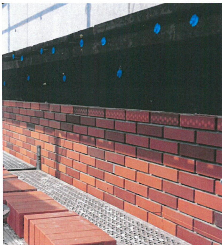
Rys. 5. HK5 - kotwy drutowe LSA
