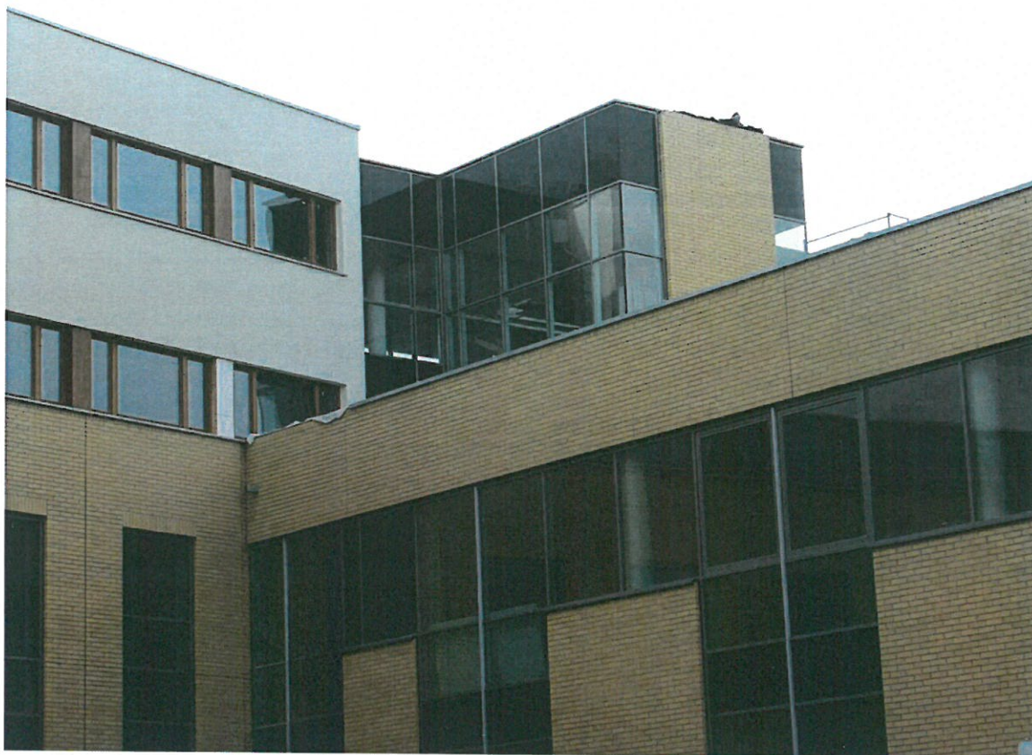
Rys. 2. Ściana i nadproże w systemie HK5
