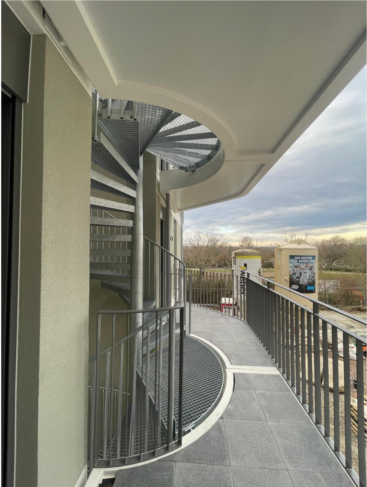
System-Stahlbalkone mit Spindeltreppe. Foto: Spittelmeister
