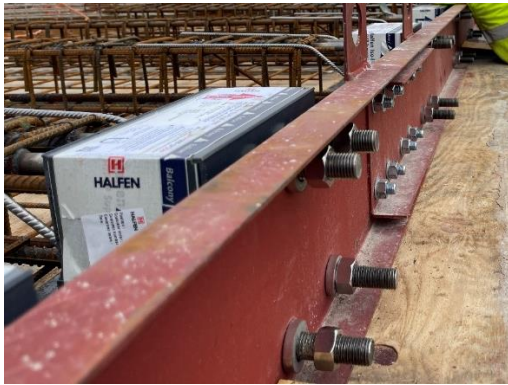
Halfen HIT Anschluss Stahl an Beton HIT-SP SDV. Foto: Leviat
