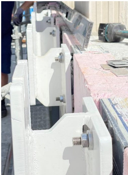
Einbau der Halfen HIT-SP SDV. Foto: Spittelmeister
