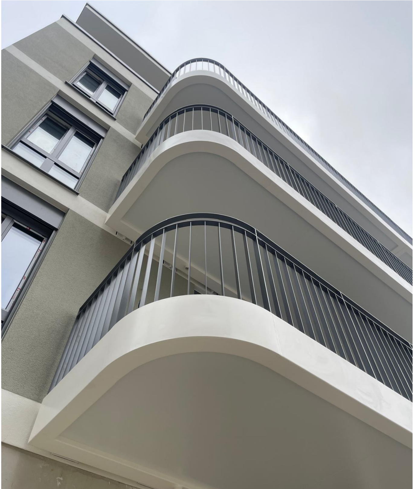
System-Stahlbalkone. Foto: Spittelmeister
