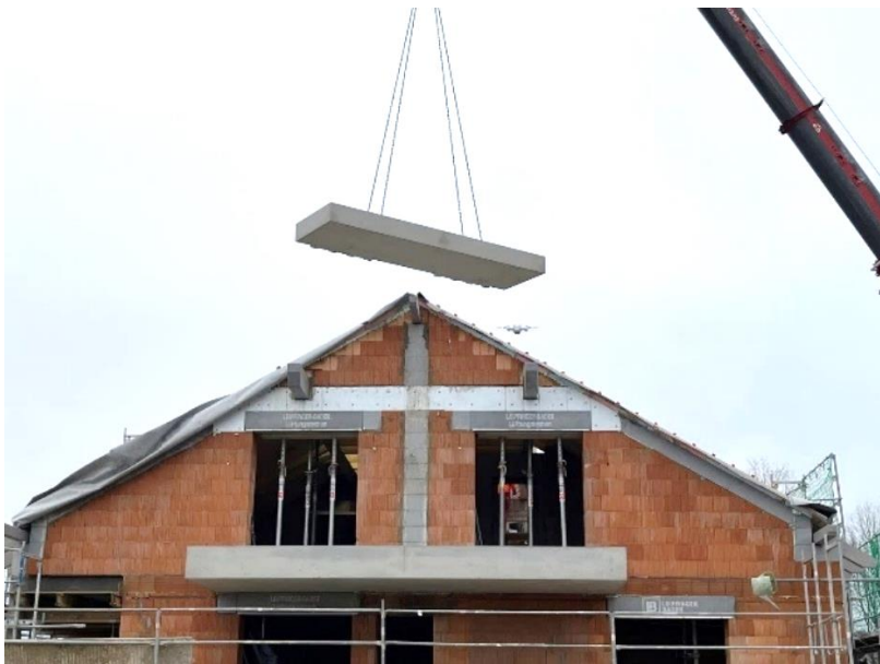
Montage der Fertigteilbalkone auf der Baustelle. Foto: Leviat GmbH / dechant
