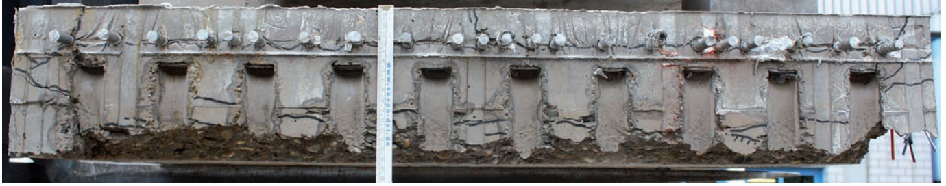
Bild 4 Bruchbild bei Betonkantenbruch Fracture picture in Concrete edge failure
