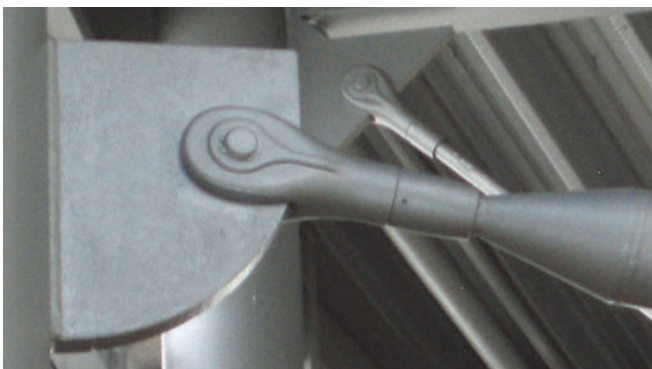
Verbindung Druckstabsystem an Anschlussblech
