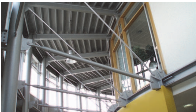
Abstützung zwischen äußeren Stahlstützen und innen liegenden Stahlträgern
